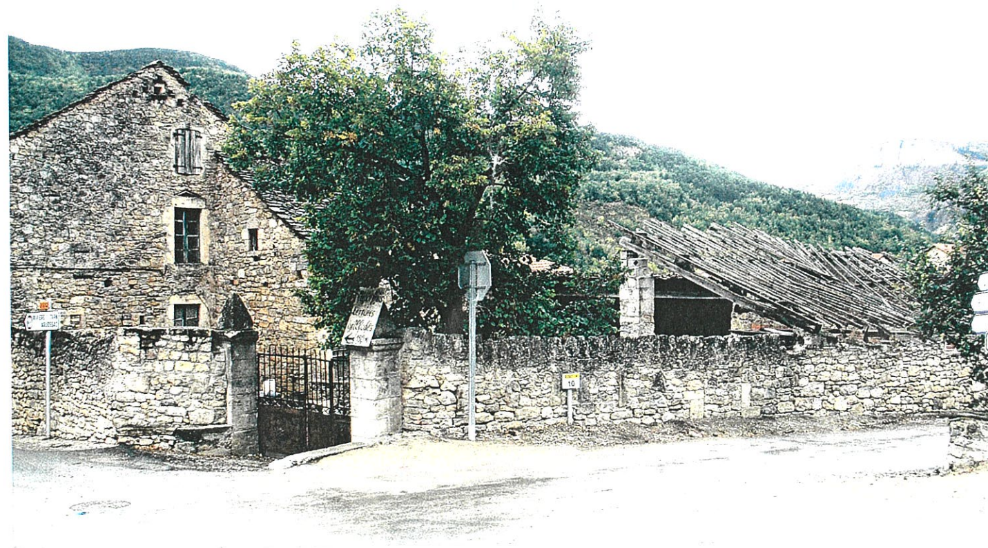
Carrefour avant les travaux
