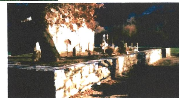
Réfection du mur du cimetière de PINET
