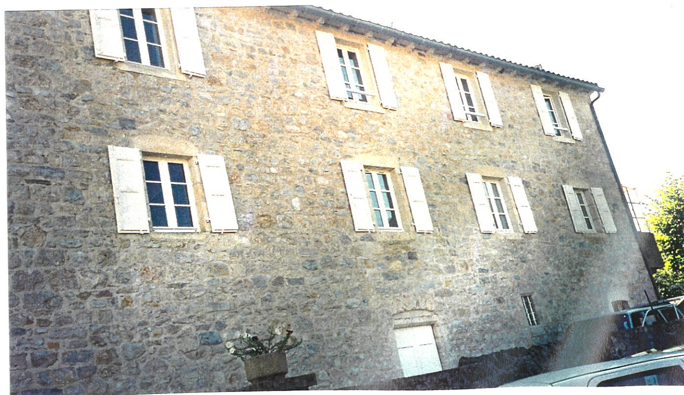
ENTRETIEN DES MENUISERIES DES APPARTEMENTS DU PRESBYTERE
