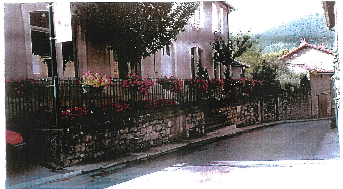
Avant rénovation de la façade
