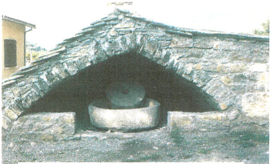
Cette petite voûte abritait le bois pour alimenter le four et héberge maintenant le moulin à huile (curiosité pour les touristes )
