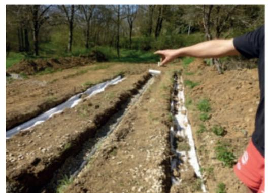
Des tranchées d'épandage installées sur un sol adapté : un sol de nature filtrante.
