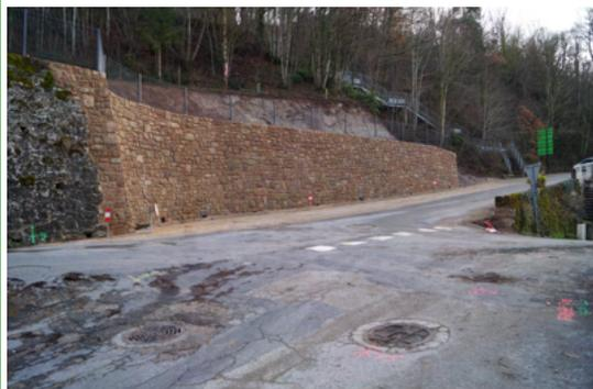
Une fois le mur terminé un grillage a été mis en place sur la longueur du mur pour la sécurité. Les têtes de murs au centre de la chaussée ont également été refaites.
