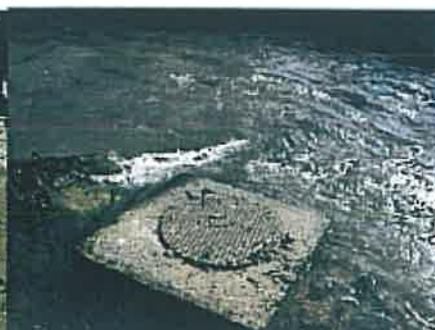
*Photo 5 : Réseau de collecte submergé*
