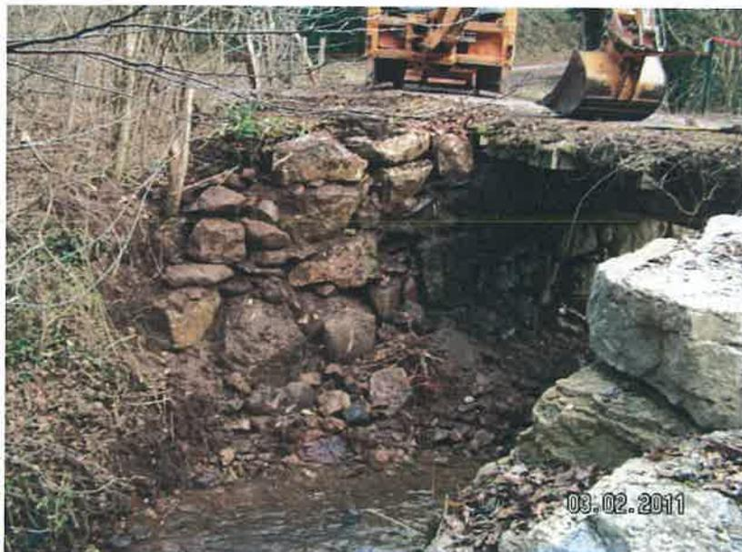
A la Fagette, les employés communaux ont réalisé un enrochement afin de consolider le pont.
