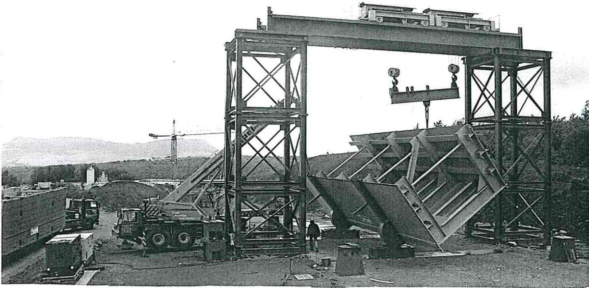
Arrivée et retournement des demi-caissons avant assemblage sur l'aire de lancement.
