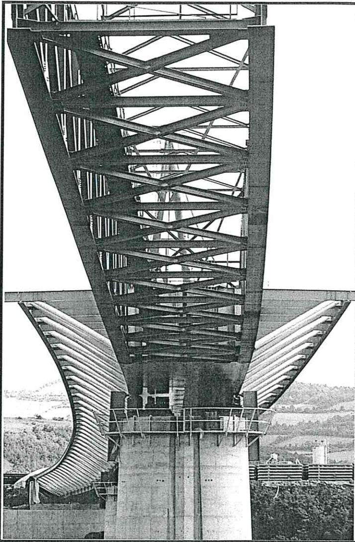
La charpente métallique repose déjà sur 2 piles
