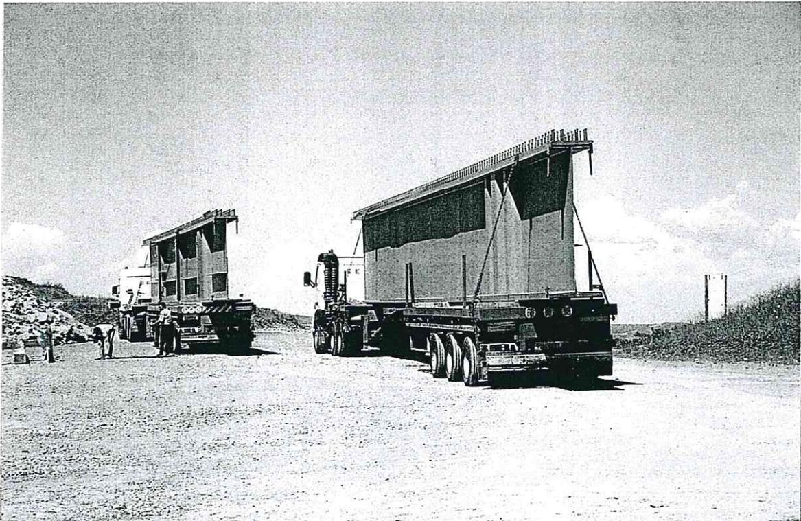
Arrivée par convoi exceptionnel des tronçons des poutres de la deuxième charpente. Chaque tronçon pèse de 25 à 45 tonnes.
