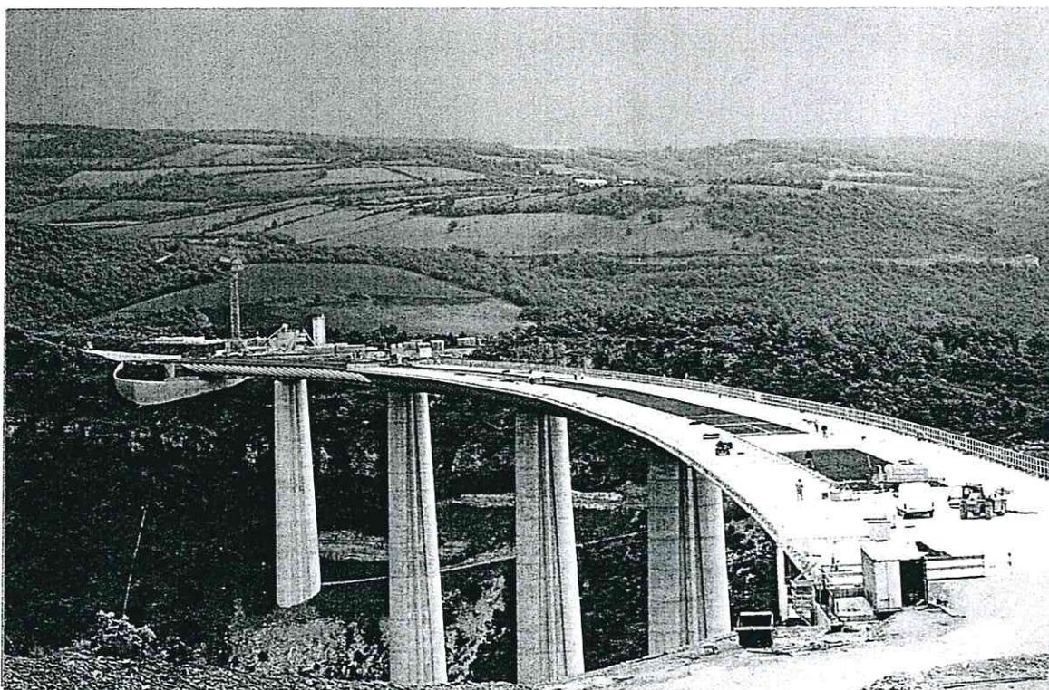
Bétonnage de la partie centrale du tablier par plots de 25 m
