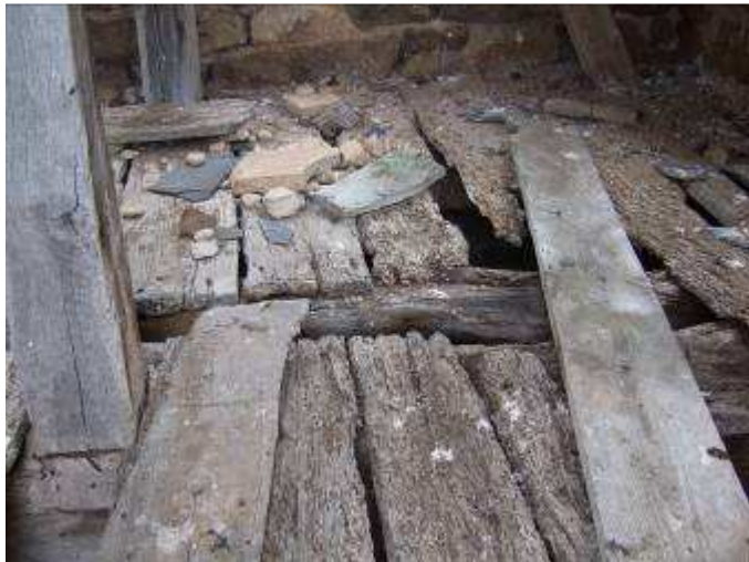
Le plancher du clocher avant ...
