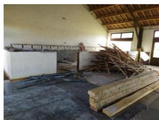
A ce jour, les maçons ont procédé à la démolition intérieure : protection du parquet, dépose de l'estrade, du faux plafond et des sanitaires. Début janvier, débutera le renforcement de la charpente. Suivront la dépose des anciennes menuiseries et la pose des nouvelles. Le plaquiste pourra alors intervenir. Coté place, les fouilles et les fondations de l'extension ont été réalisées.
