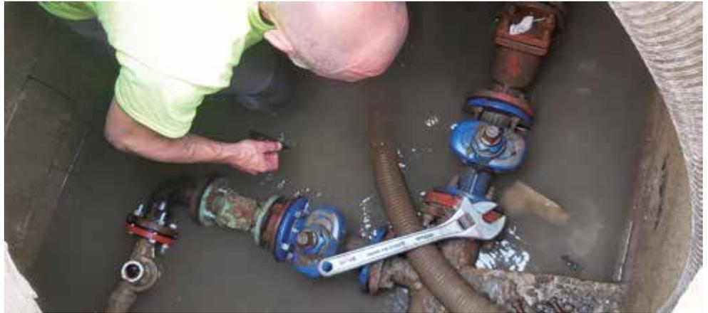
Réparation de plusieurs fuites sur le réseau d'eau potable. Sur le village, la zone de Vergonhac et sur le hameau de Craissaguet.
