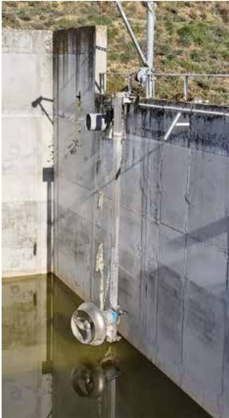
Réalisation et remplacement par le personnel communal d'un support moteur (pied d'assise), en inox pour la station d'épuration du village.
