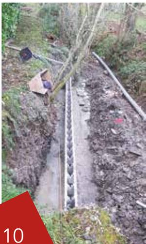
Réalisation d'une fouille et d'un mur de soutènement par le personnel communal, sur les berges du Lavencou, chemin du moulin hameau de St-Geniez-de-Bertrand.
