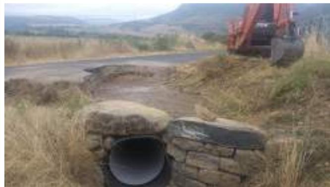
Travaux de maintenance sur la route de Craissaguet afin de reprendre des traverses de voirie pour l'évacuation des eaux pluviales.
