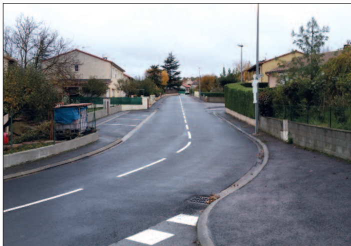
La rue des Assalisses après travaux.
