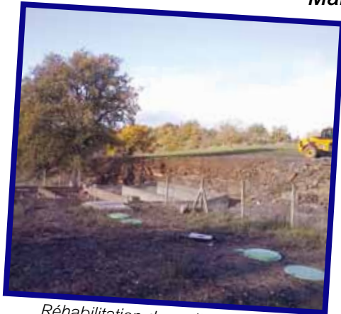
Réhabilitation de petites stations
