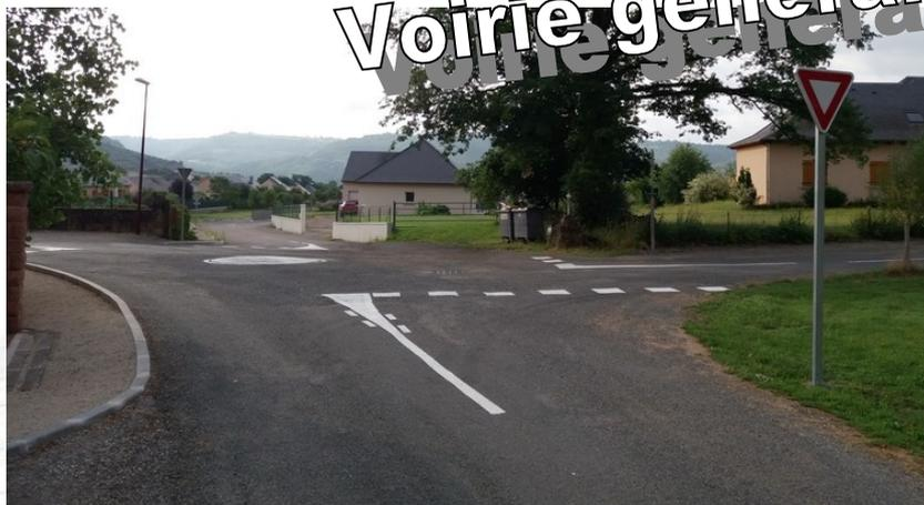
Carrefour des Eglantiers - Les Coteaux : fin d'aménagement de la voirie par matérialisation au sol d'un rond point et une signalétique verticale pour « casser » la vitesse excessive.
