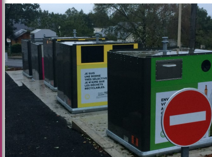
Colonnes aériennes DRIVE du Comtal à Gages
