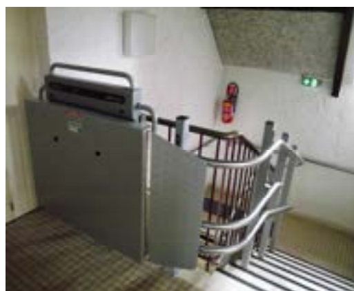
Parking de la plateforme à l'étage
