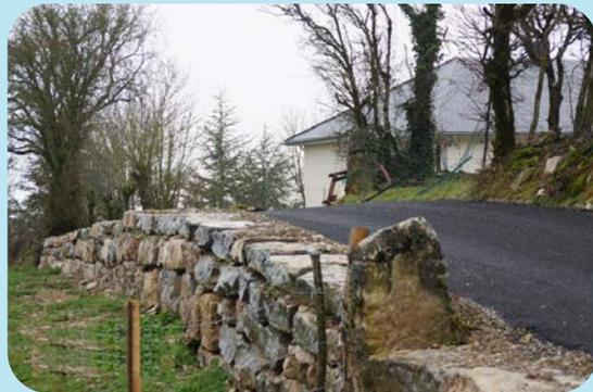
Élargissement avec la construction d'un enrochement de la voie d'accès aux nouvelles habitations de Combres
