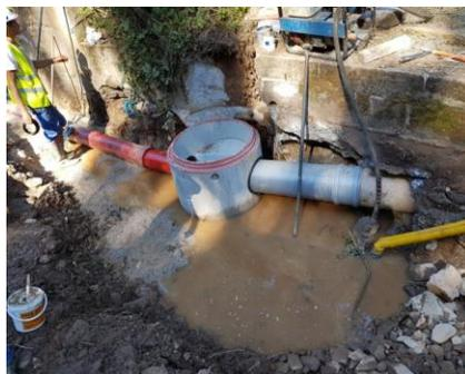
Ces travaux d'étanchéité du réseau ont permis de diminuer les entrées d'eaux parasites et d'infiltration de la rivière. Malgré cela, lors de fortes pluies le volume d'eau arrivant à la station augmente considérablement et nuit fortement au bon fonctionnement de la station.
