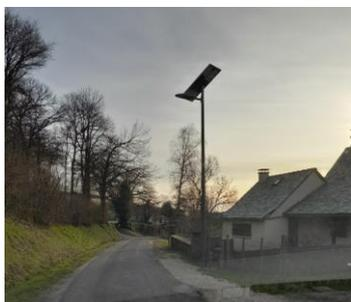
Cette opération a permis d'enfouir le réseau fibre et téléphonie et de réaliser la mise en sécurité du réseau électrique précédemment en fil nu basse tension. En ce qui concerne l'éclairage public fini les câbles réseaux, 2 candélabres photovoltaïques ont été installés.
