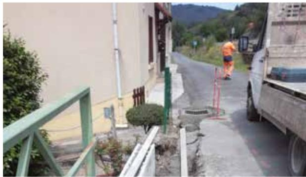
Chemin des Granges l'écoulement des eaux pluviales ne se faisait pas correctement, les services techniques sont intervenus pour mettre en place une grille pluviale et la raccorder au réseau. Ces travaux ont nécessité la reprise d'un mur de soutènement de la route.
