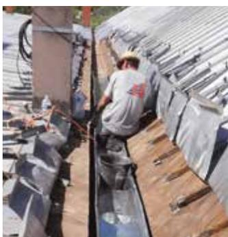
Afin de ne pas dégrader et compromettre les aménagements intérieurs faits, il a été décidé d'engager la réfection totale de la couverture permettant également de prolonger la durée
