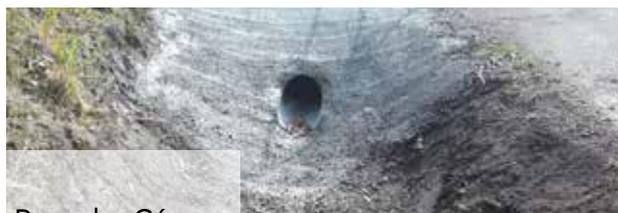
Rue de Cérons, derrière l'ex-SO-PAVE, pose d'un regard pluvial et curage du fossé.
