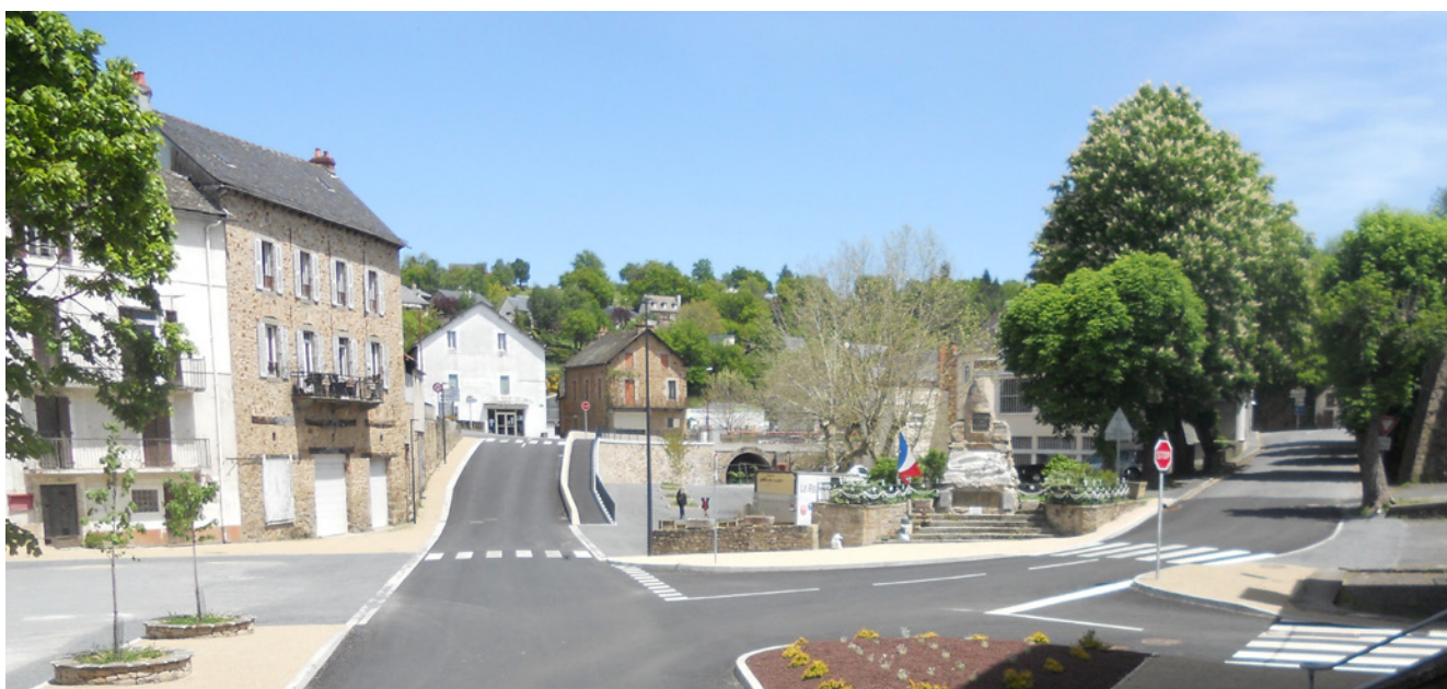
Travaux d'aménagement place du Céor, un projet communal réalisé avec le soutien financier de Pays Ségali Communauté, du conseil départemental de l'Aveyron, de la région Occitanie et de l'État.
