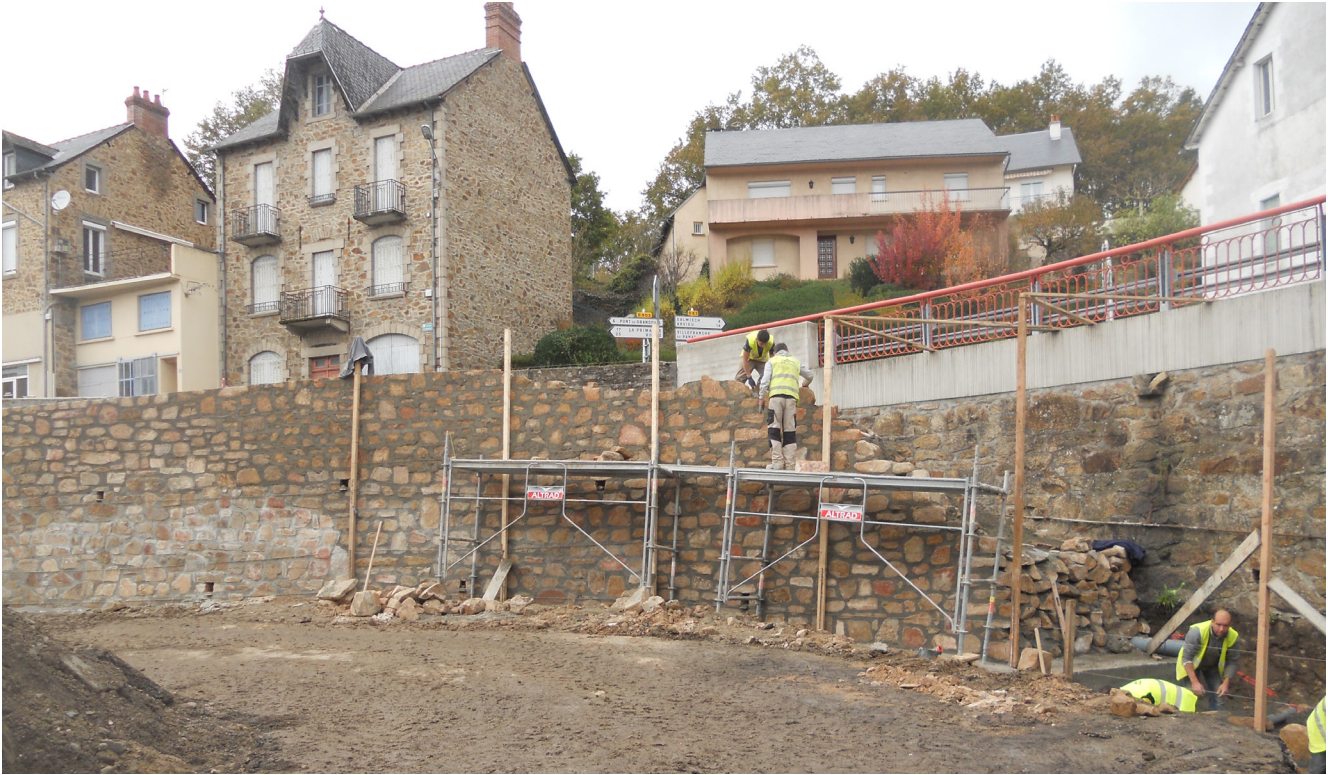
Les travaux en cours place du Marché
